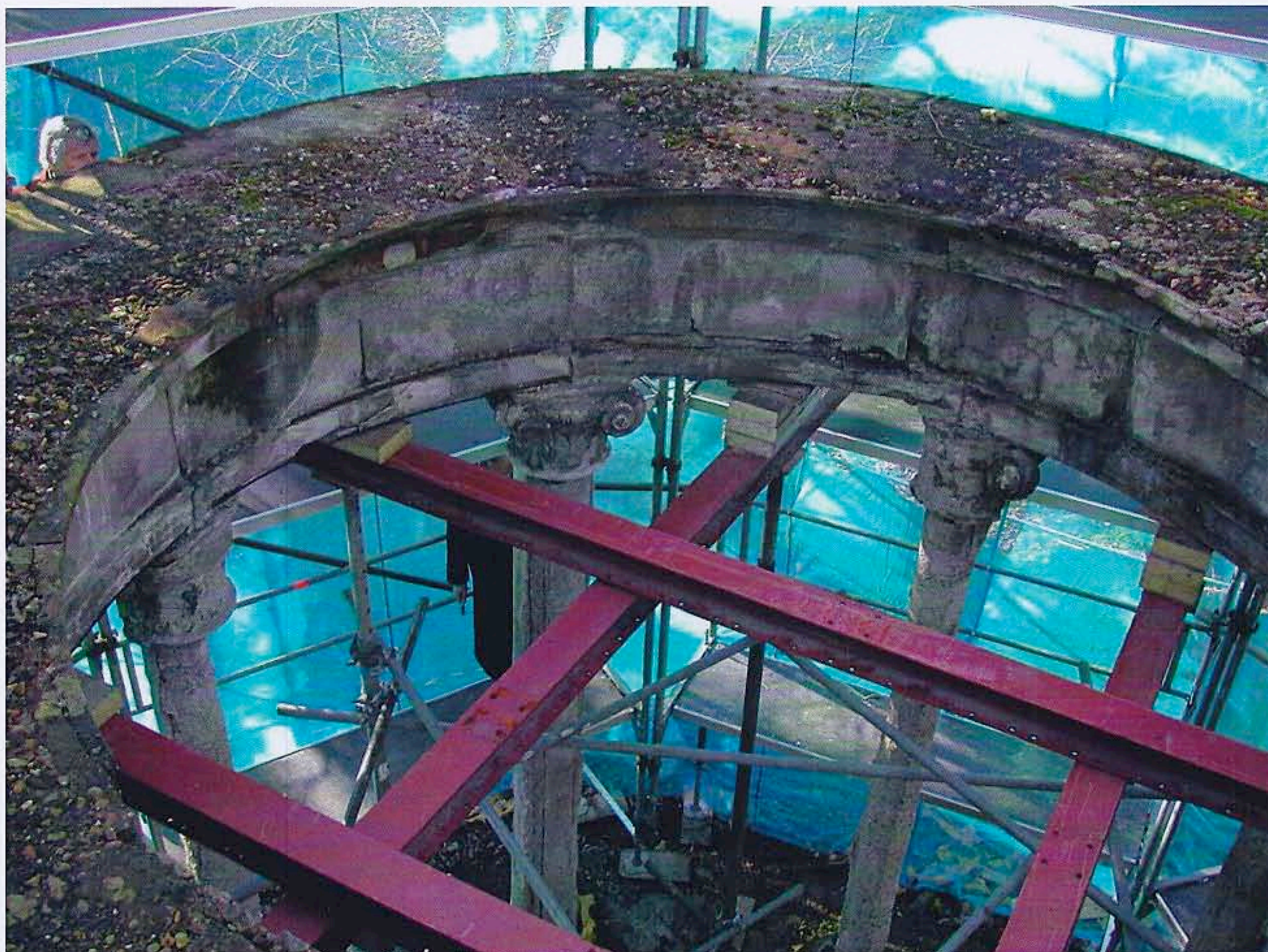
Bovenaanzicht van het koepeltje waar vroeger het dak op lag, nu gestut door stalenbalken om verder verval te voorkomen.
